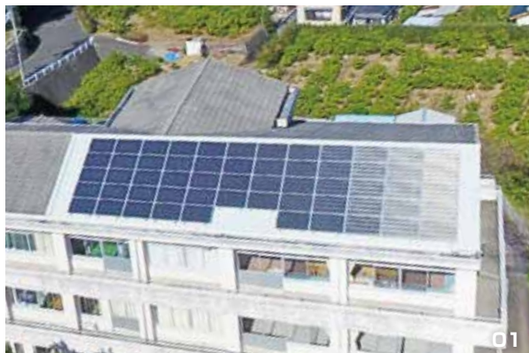
01. 井田小学校の屋根に設置された太陽光パネル。 02. 相野谷中学校に設置された蓄電池。
