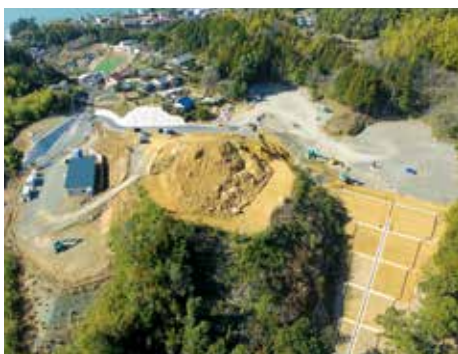
大規模災害時の避難場所、活動拠点となる成川高台整備
