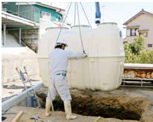
浄化槽設置の様子
