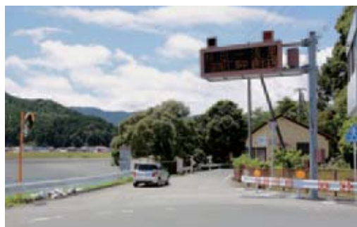
7 月 24 日に通行規制が解除され、浅里まで通行可能となった県道小船紀宝線
