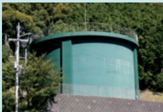
井田上野配水池
