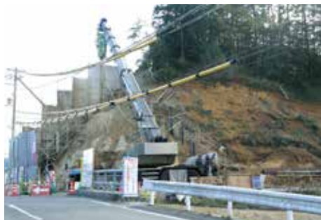
紀宝ランプ橋下部工事
