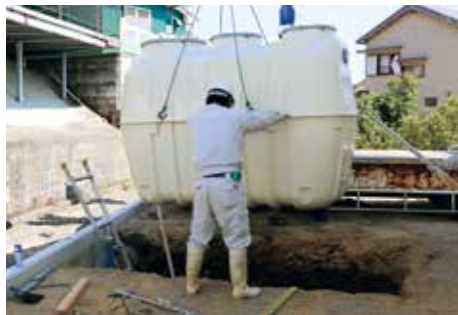
合併処理浄化槽
