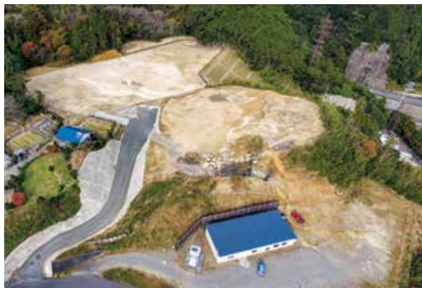
成川高台公園整備
