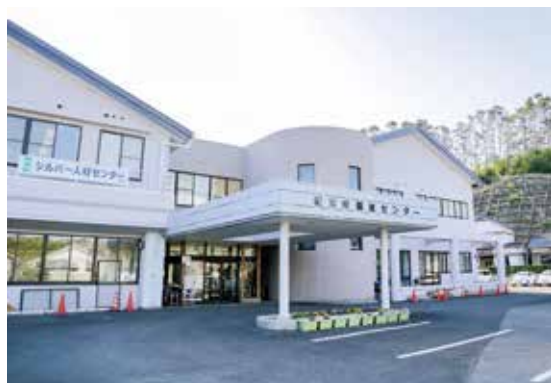
改修工事を行っている紀宝町福祉センター
