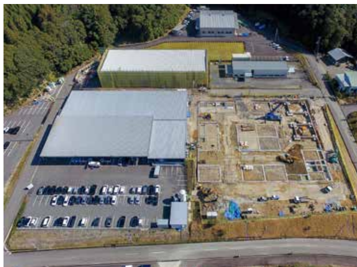
整備が進む井内工業団地
