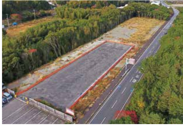
整備が進むウミガメ公園横の保安林
