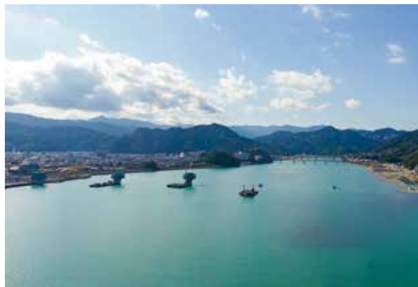
整備が進む新宮紀宝道路熊野川河口大橋
