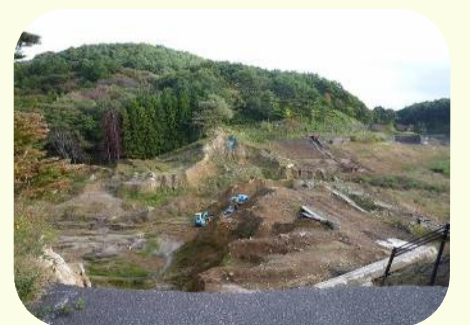
藤沼湖被災状況
