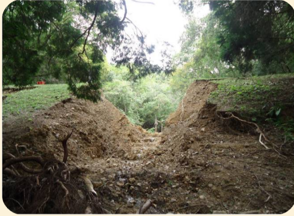
平成25年9月、台風18号による大雨により決壊したため池(津市)
