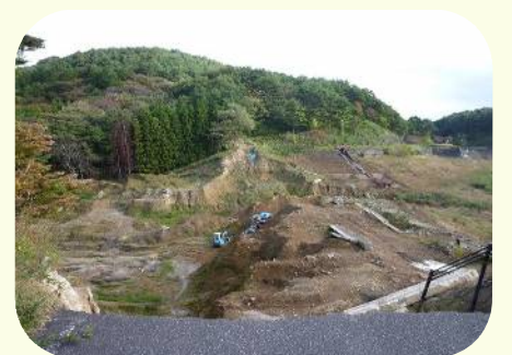
藤沼湖被災状況
