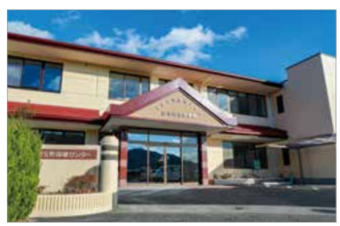
1月末で工事が完了し、引越し作業が進む複合施設
