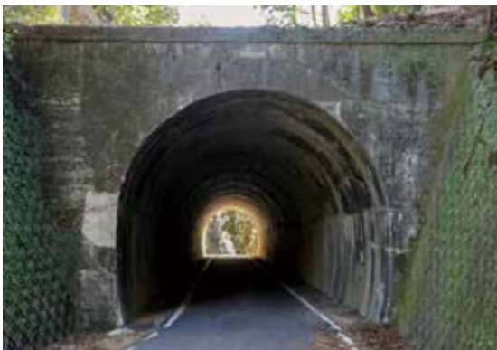
封鎖される旧相野谷トンネル
