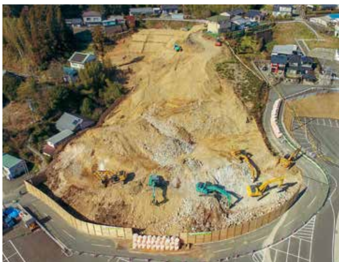
新築工事が進む鵜殿保育所
