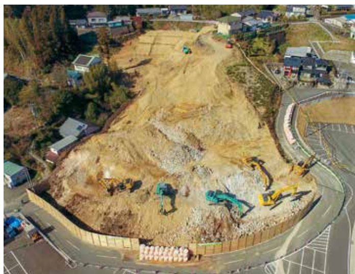
新築工事が進む鶴殿保育所
