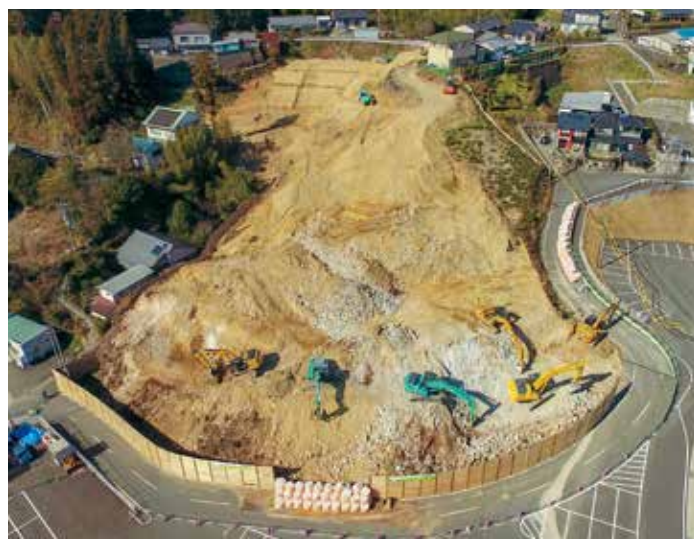
新築工事が進む鵜殿保育所
