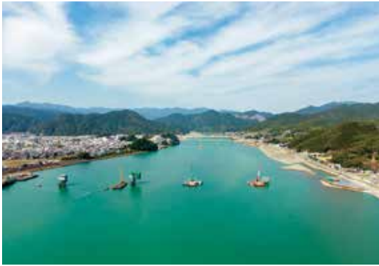
整備が進む新宮紀宝道路熊野川河口大橋
