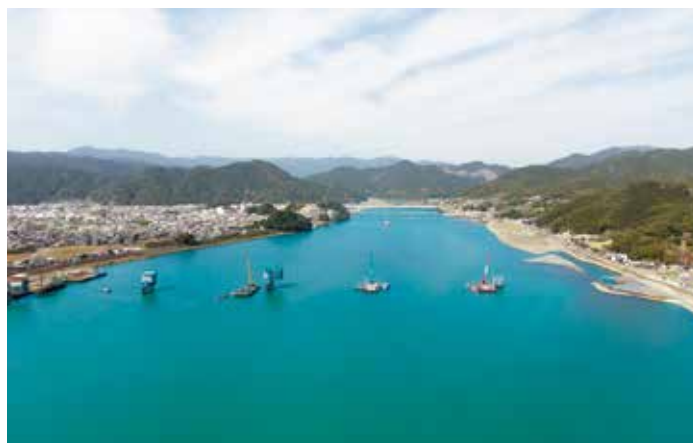
新宮紀宝道路熊野川河口大橋の進捗状況(全体)
