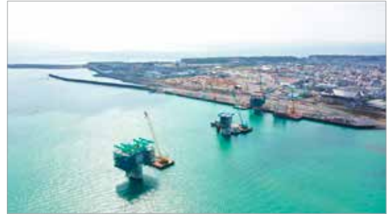
②熊野川河口付近
