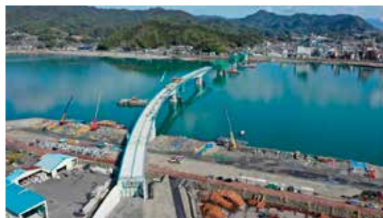
②熊野川右岸側付近
