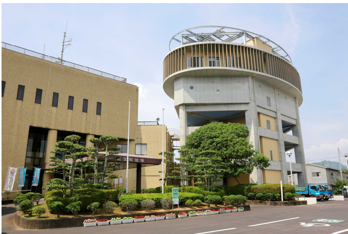
写真 4-4 紀宝町防災拠点施設（紀宝町役場と隣接する津波避難ビル、6階建）
