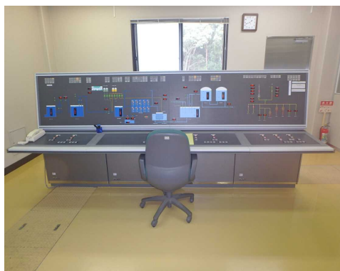
写真 4-2 御船浄水場 監視盤
