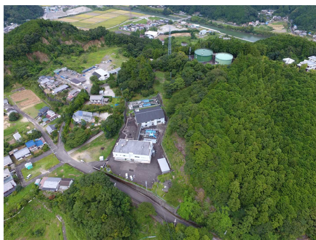
写真 4-3 御船浄水場全景 ～右上に配水池 2 池～
