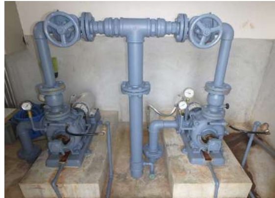
写真 4-26 成川上地・七瀬加圧ポンプ所 (成川上地ポンプ)
