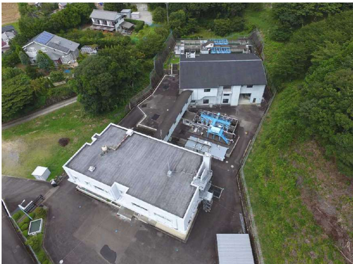
写真 2-1 御船浄水場全景
