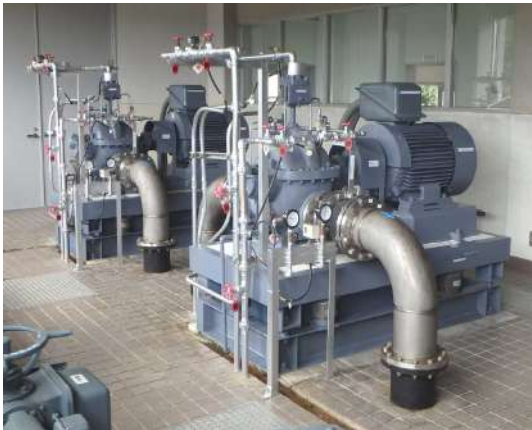
写真 4-23 御船浄水場 送水ポンプ
