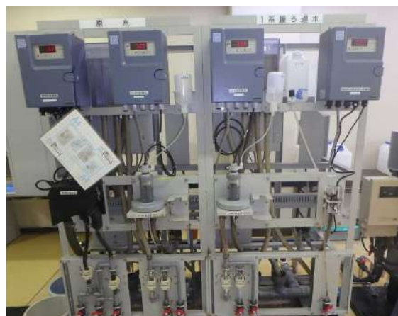
写真 4-16 原水・膜ろ過水水質監視設備
