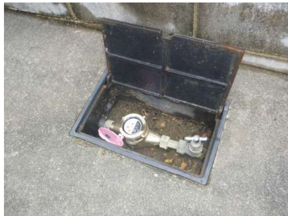
写真 4-39 一般家庭用水道メーター設置例
