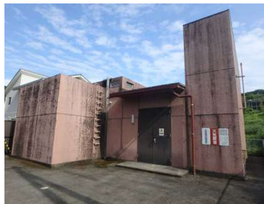
写真 4-22 神内加圧ポンプ場全景
