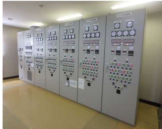
写真 4-14 膜ろ過施設制御盤
