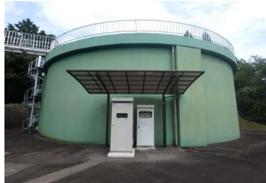
写真 4-18 御船配水池 2 号池
