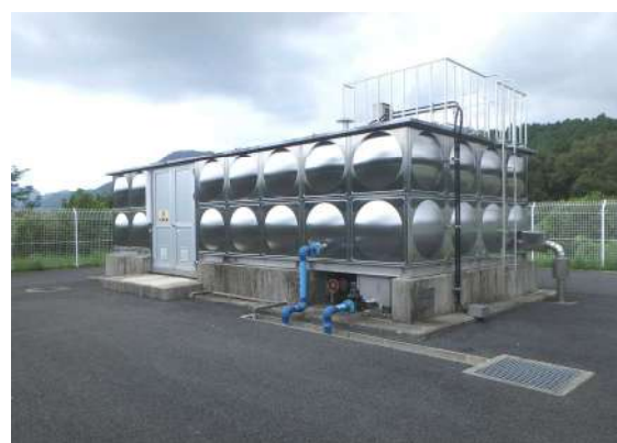
写真 4-28 大里加圧ポンプ所
