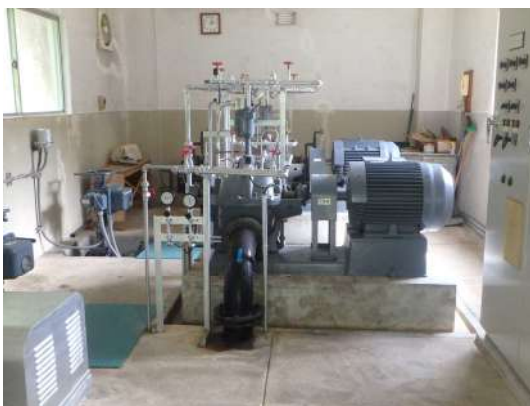
写真 4-9 導水設備 (導水ポンプ)
