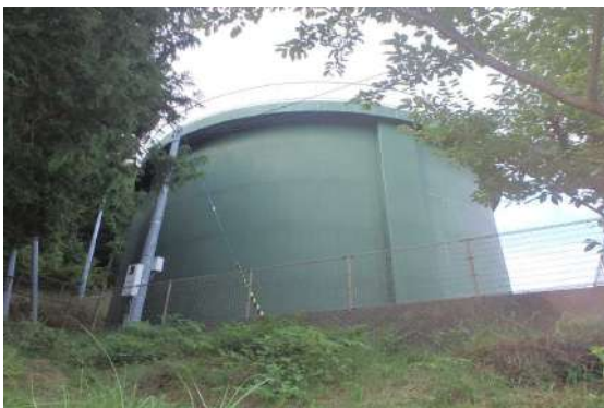
写真 4-19 上野配水池 (1 池)
