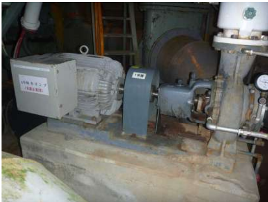
写真 4-7 取水設備 (取水ポンプ)
