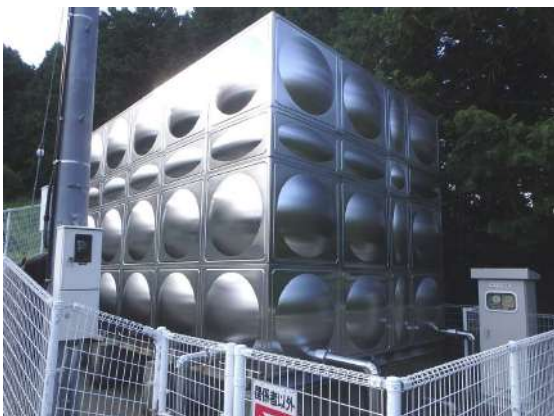
写真 4-21 七瀬配水池 (1 池)
