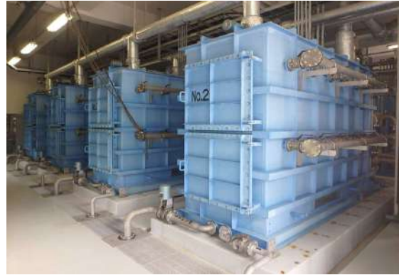
写真 4-12 膜ろ過設備 (膜ろ過棟内)
