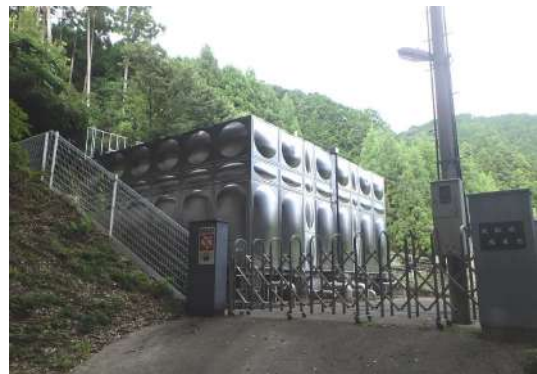
写真 4-20 阪松原配水池 (1 池)
