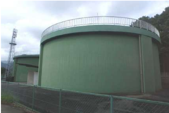
写真 4-17 御船配水池全景 (2 池)
