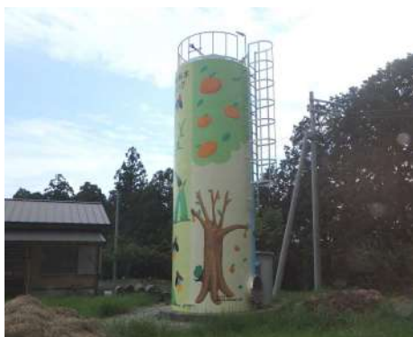
写真 4-31 津本防災センター
