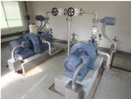
写真 4-25 阪松原加圧ポンプ所 ポンプ
