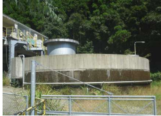
写真 4-6 取水設備 (取水ポンプ室)
