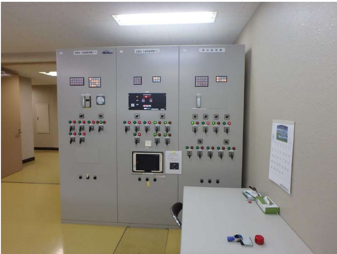
写真 6-6 御船浄水場 浄水処理システム監視盤
