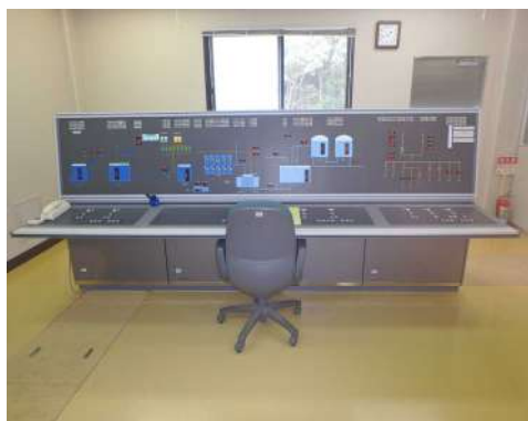
写真 4-3 御船浄水場 監視盤
