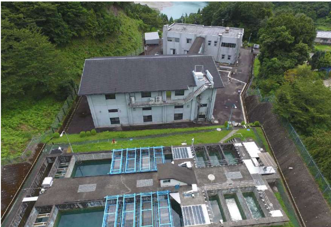
写真 6-1 御船浄水場 薬品沈殿池（前方）、膜ろ過棟（中央）、管理棟（後方）
