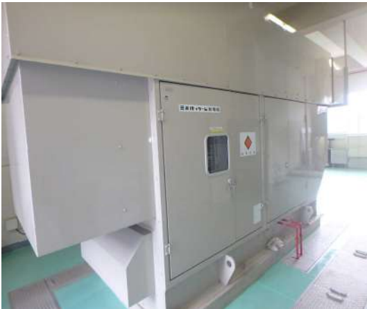
写真 4-13 自家発電設備
