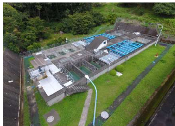
写真 4-10 沈殿池設備 (凝集池・薬品沈殿池等)
