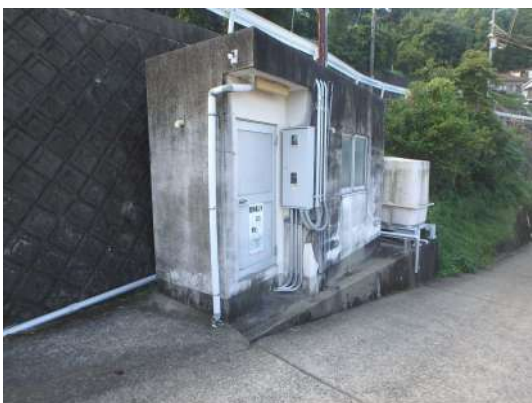
写真 4-27 成川加圧ポンプ所
