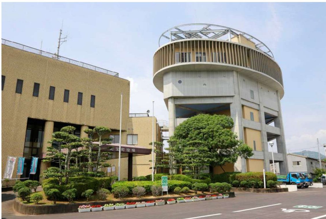
写真 4-30 紀宝町防災拠点施設（紀宝町役場と隣接する津波避難ビル、6 階建）
