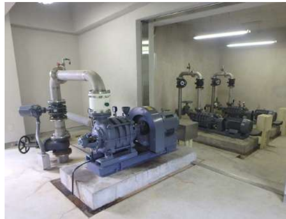
写真 4-24 神内加圧ポンプ所 ポンプ
