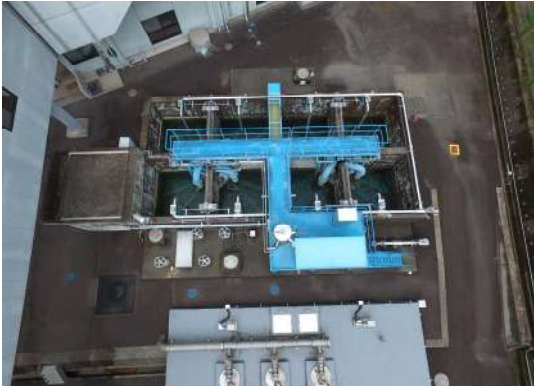
写真 4-11 急速ろ過設備
