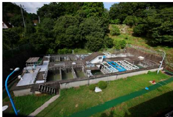
写真2-2 御船浄水場沈殿池設備
