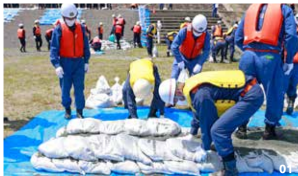
01. 町消防団による改良積土の工法。02. ヘリコプターによる救助の様子。
