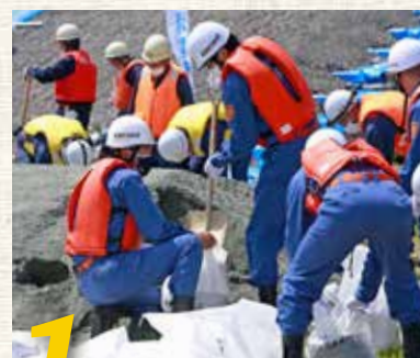
2 隙間なく土のうを並べる
