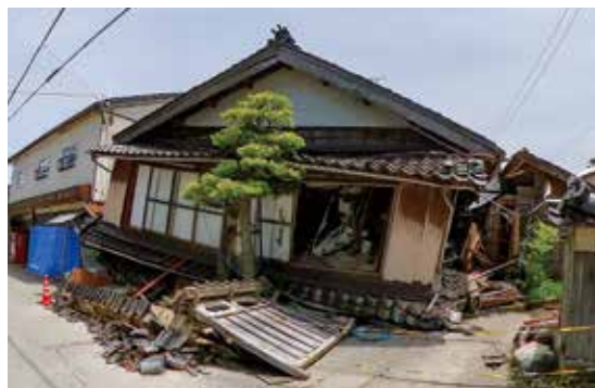
②耐震補強を行っていなかった住宅
