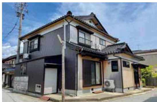
①耐震診断・補強を行っていた住宅
