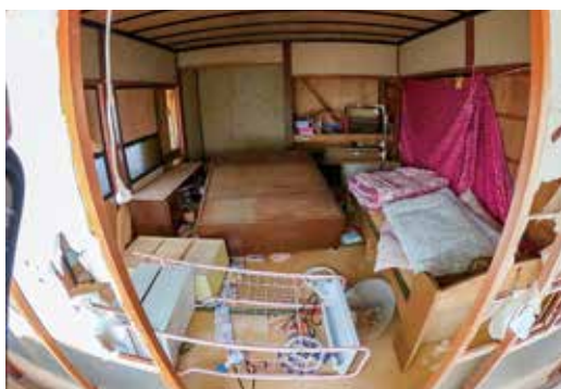
家具が倒れ散乱した寝室
