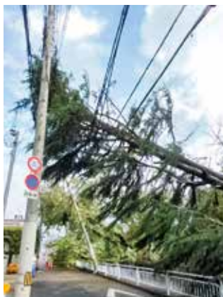
樹木が倒れ電線が損傷
