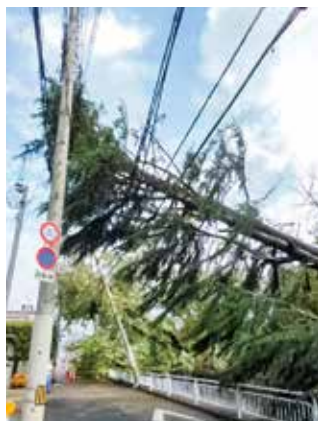
樹木が倒れ電線が損傷
