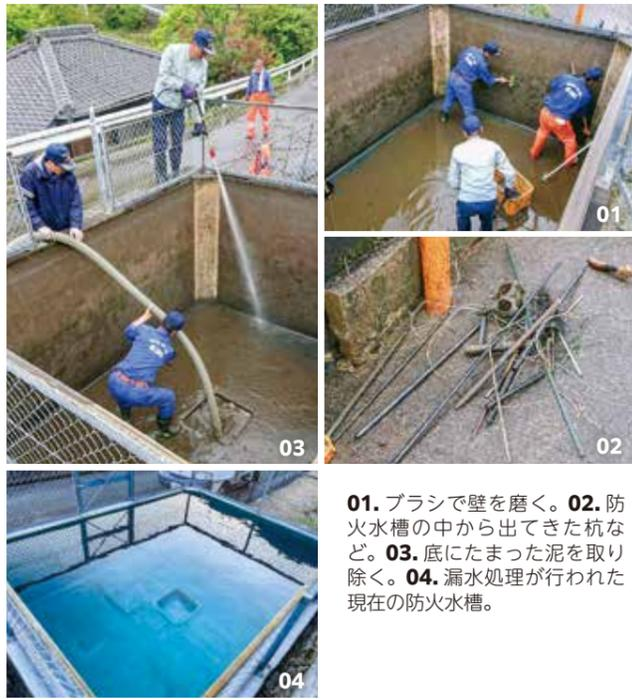
01. ブラシで壁を磨く。02. 防火水槽の中から出てきた杭など。03. 底にたまった泥を取り除く。04. 漏水処理が行われた現在の防火水槽。
