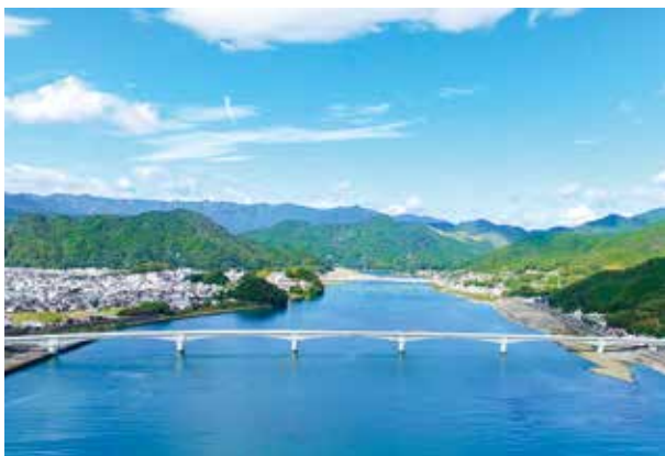
連結した新宮紀宝道路熊野川河口大橋
