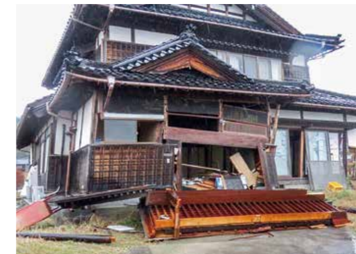
能登半島地震で被災した家屋（提供：石川県中能登町）
