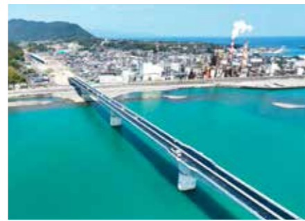
③熊野川左岸側付近
