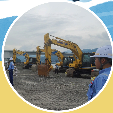
工事車両見学
