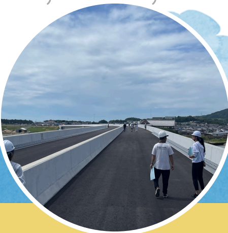
工事中の道路見学
