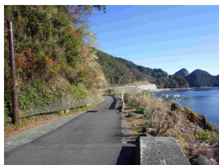
国道 311 号 狭隘箇所[熊野市]
