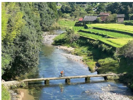
尾川川沈下橋[熊野市]
