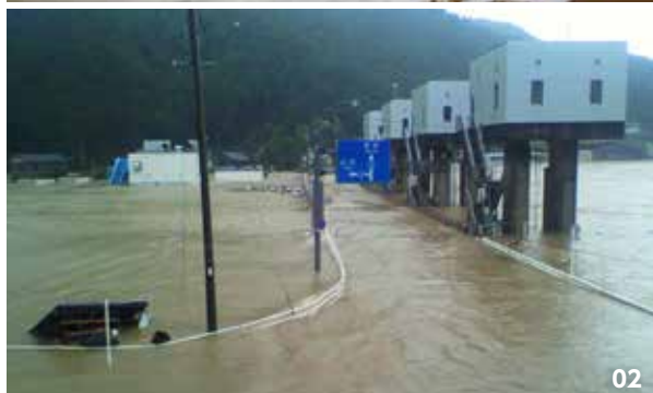
01. 伊勢湾台風で熊野川が氾濫し、成川地区が浸水する様子（紀宝町役場所蔵）。02. 紀伊半島大水害時の鮎田水門付近の様子。
