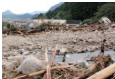
土砂崩れにあった明和小学校（左上）。見えているのは校舎の2階部分。
