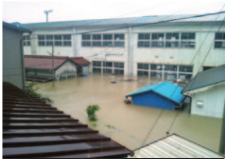
13 成川小学校 小学校の1階部分はすべて浸水し、多大な被害を受けた。 (9月4日 6時4分撮影)
