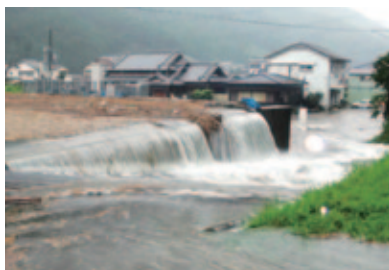
高さ9.4mの輪中堤を越え、団地へと水が浸入する様子。（9月3日 17時9分）
