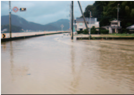
12 鶴殿地区 国道42号の矢淵付近は、一時、堤防が隠れるほど浸水する。 (9月4日 11時13分撮影)
