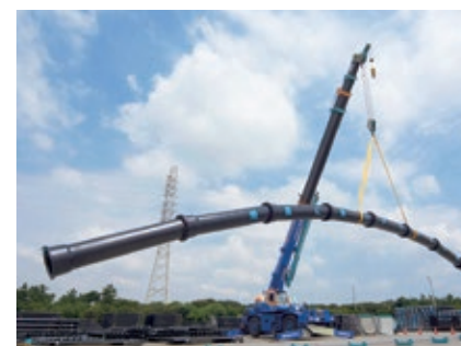
耐震管の吊り上げ実験の様子 （写真提供：日本ダクタイル鉄管協会）
