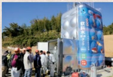
成川に設置された飲料水兼用耐震性貯水槽
