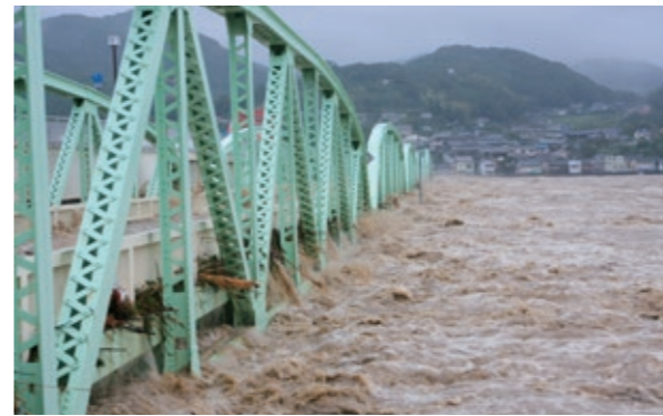
平成23年台風第12号で通行不能となった旧熊野大橋
