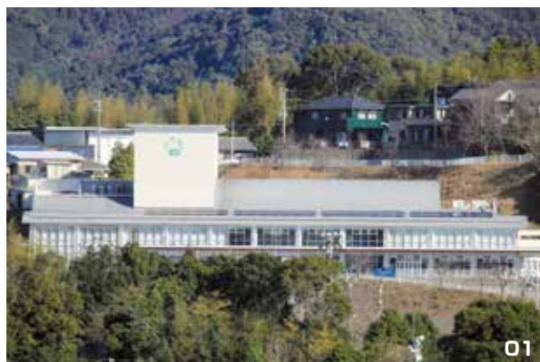
01・02. まなびの郷の屋根 に設置された太陽光パネル。
