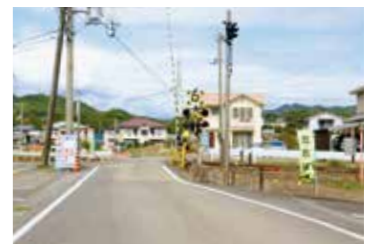
拡張工事を行う鵜殿小学校前踏切
