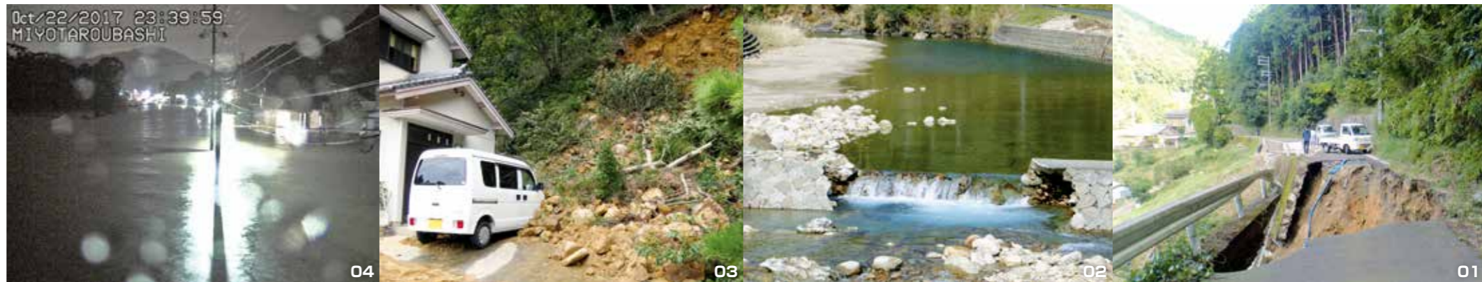
01. 道路が大きく陥没した成川地区の町道七滝線。02. 河川の増水により堰（せき）が崩れた相野谷川。03. 民家の近くでも土砂崩れが発生。04. 飯盛地区では浸水被害が発生。
