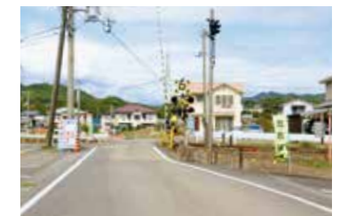
拡張工事を行う鵜殿小学校前踏切
