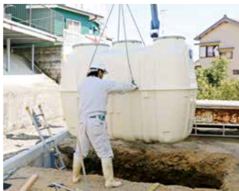
浄化槽設置の様子
